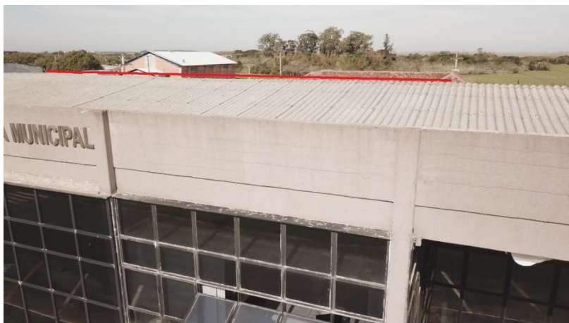
Foto 33 - Vista da cobertura posição central/leste ilustrado
