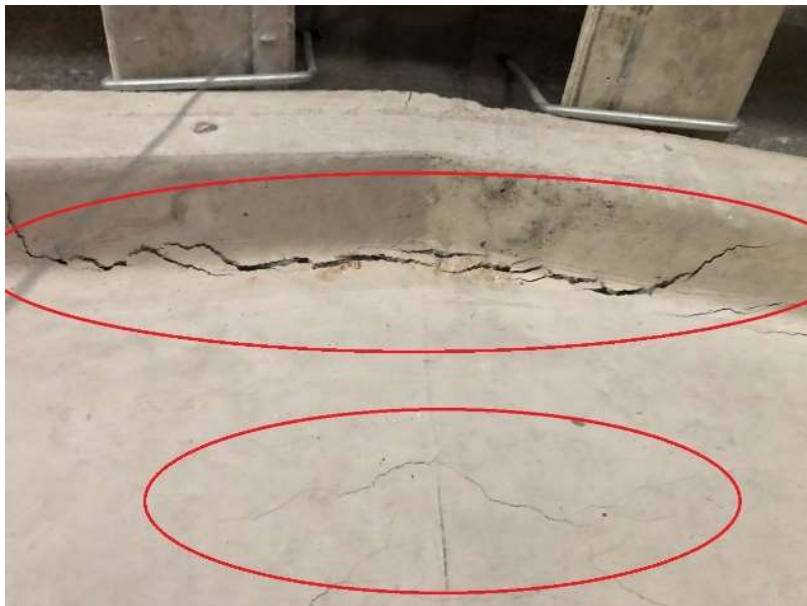
Foto 11 - Trincas e fissuras horizontais da viga braço
