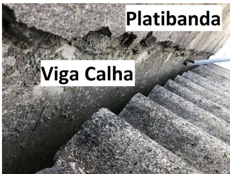
Foto 26 - Ligação entre viga calha e platibanda
