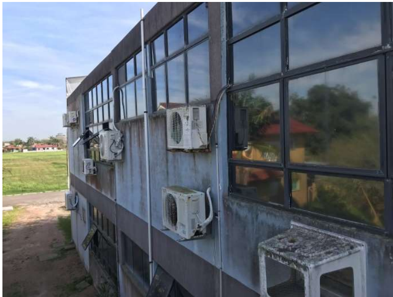
Foto 50 - Pintura degradada
