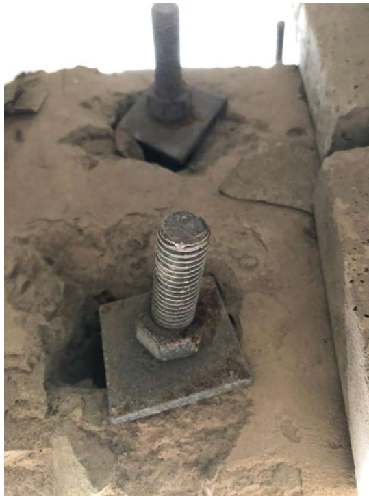
Foto 19 - Ponto de ligação entre pilar e viga de cobertura
