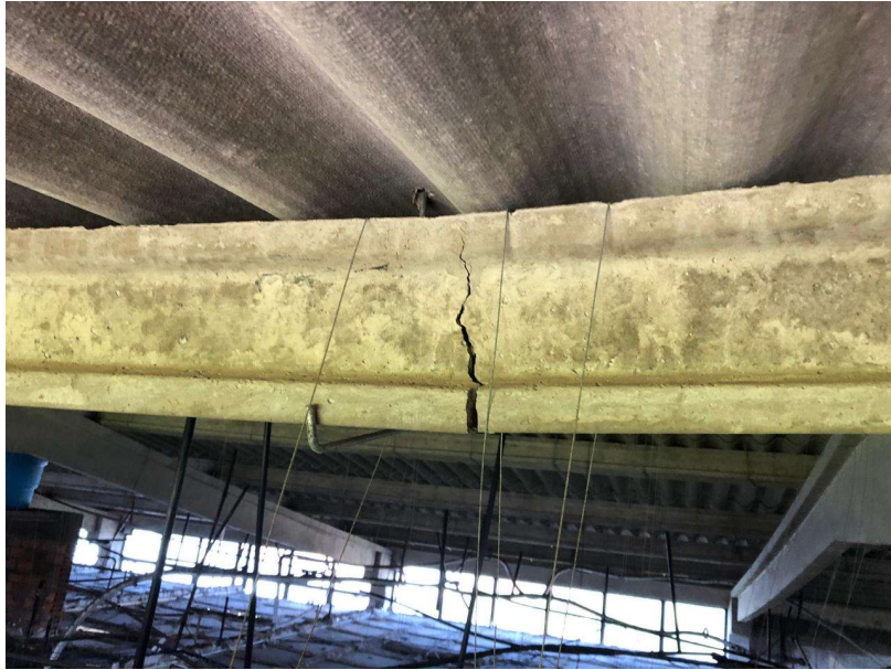
Foto 31 - Vista inferior do ponto de flexão
