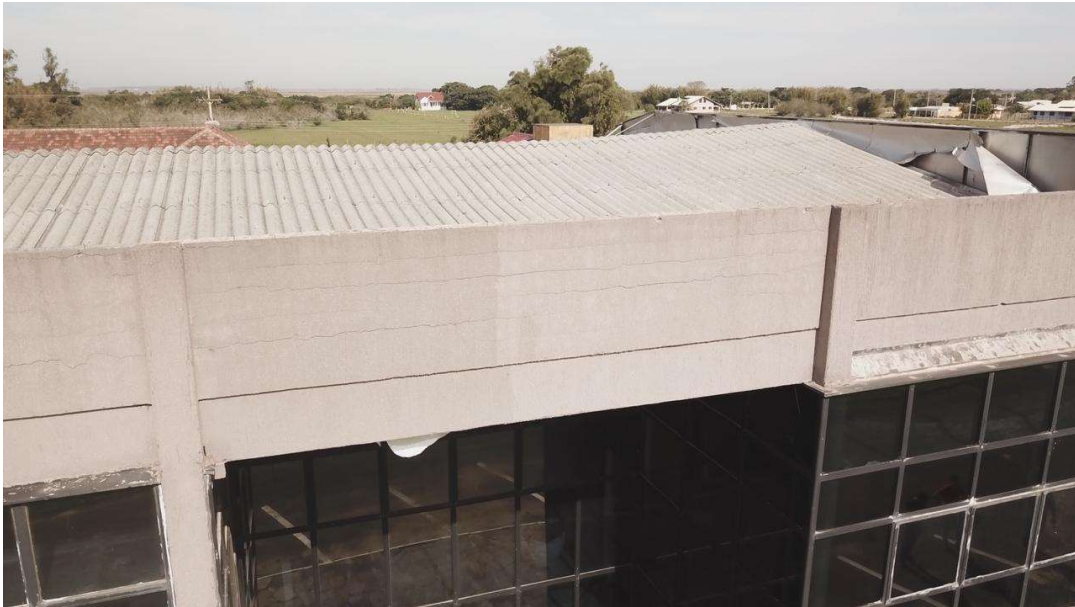
Foto 27 - Vista da cobertura parte oeste
