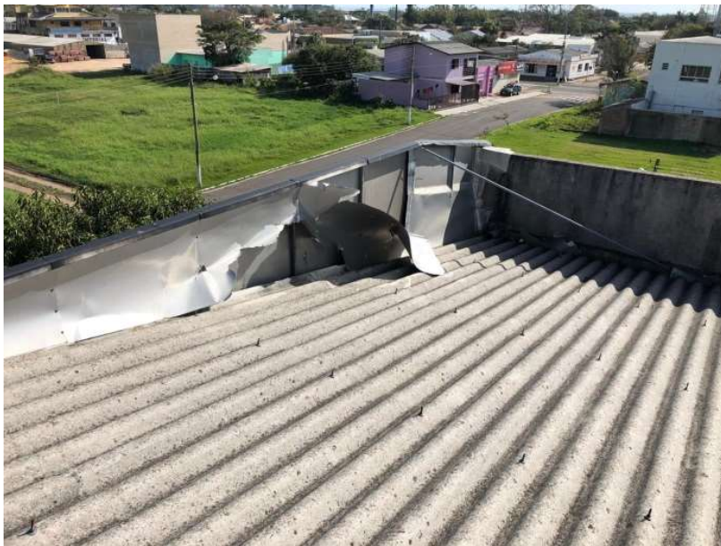
Foto 53 - Rufos metálicos de platibanda lateral oeste
