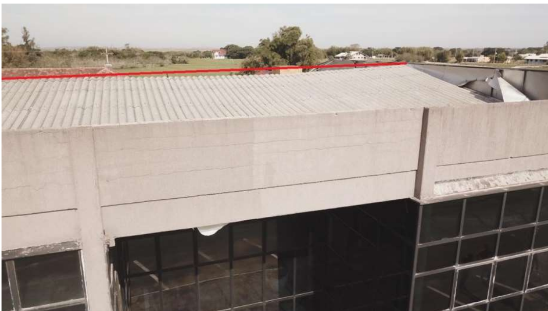
Foto 28 - Vista da cobertura parte oeste ilustrado
