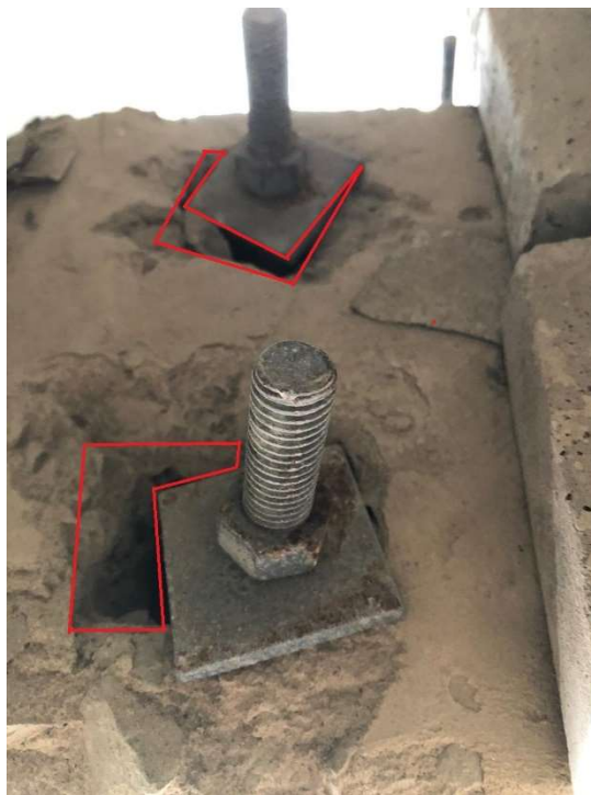
Foto 20 - Ponto de ligação entre pilar e viga de cobertura ilustrado
