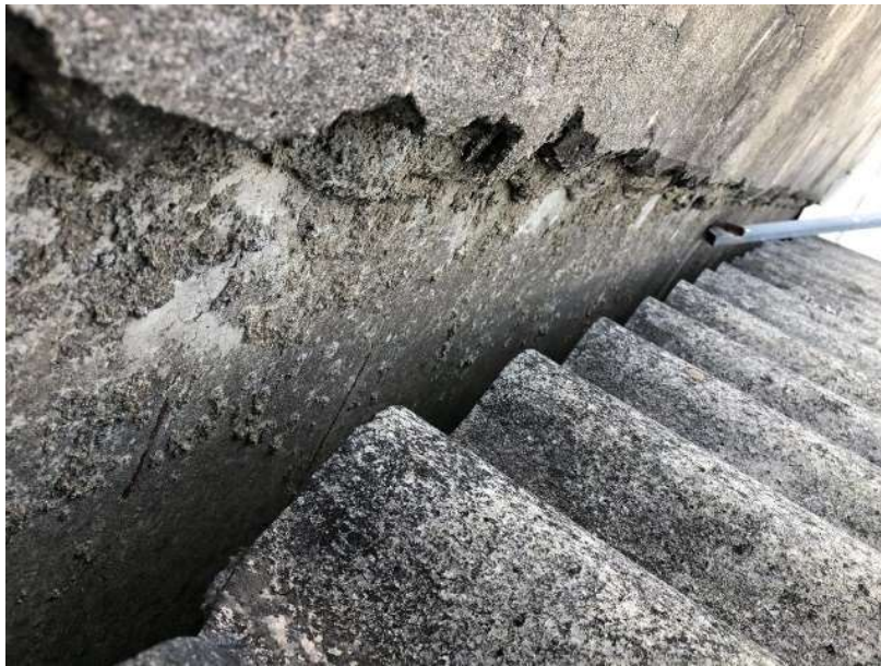
Foto 25 - Ligação entre viga calha e platibanda
