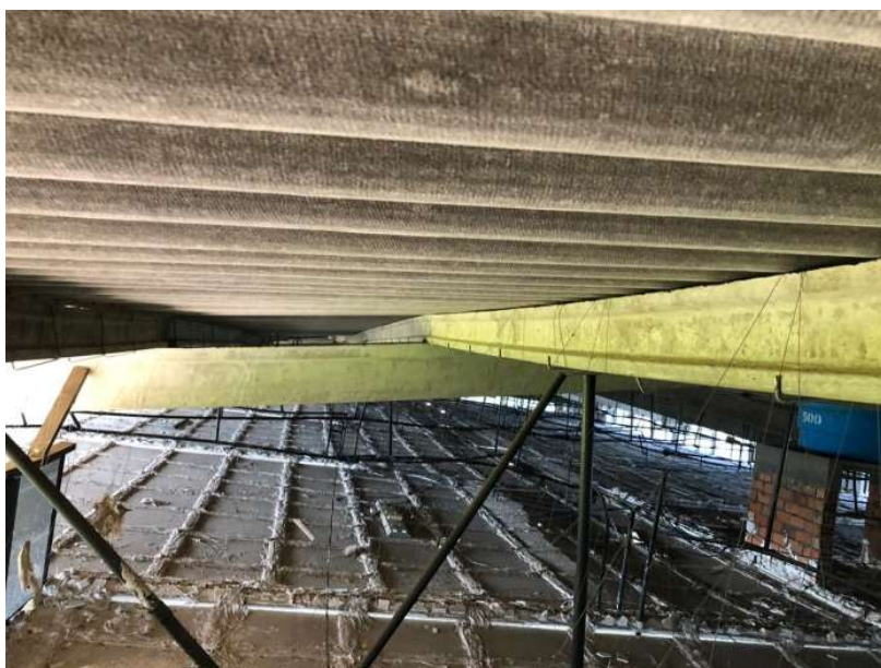
Foto 13 - Flexão de vigas terça
