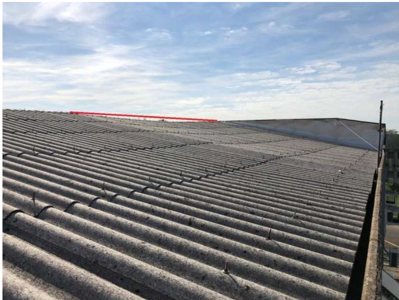
Foto 30 - Vista aproximada do ponto de flexão da cobertura lado oeste ilustrado
