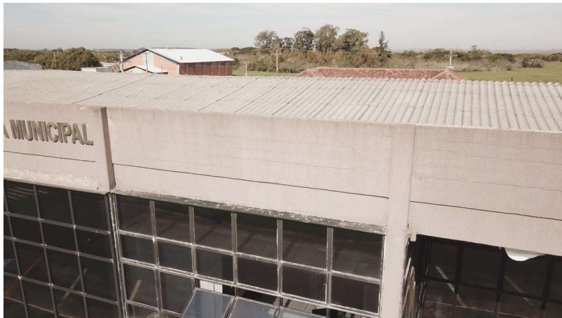
Foto 32 - Vista da cobertura posição central/leste
